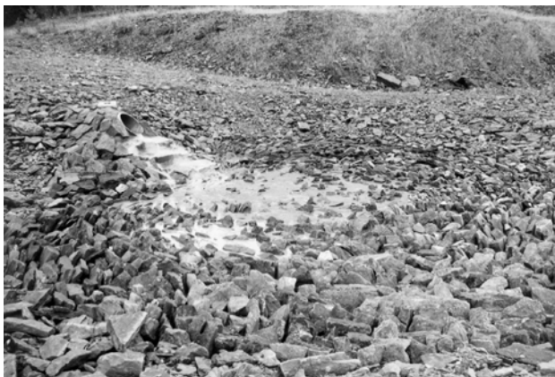
Abb. 4: Versturzpunkt (28) der Haldensickerwässer in den Bereich der Bruchzone (Prinzler/Leimgrübner Gangzug) (links)
